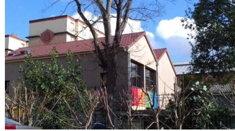
La couverture de l'Atelier est terminée !
